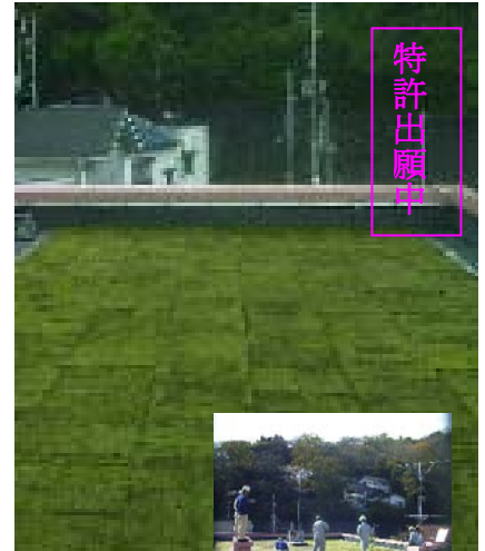
兵庫県公舎屋上施工中
