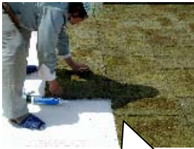
「モスフラット」施工中
