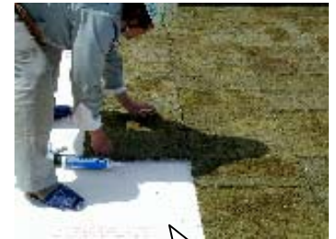
「モスフラット」施工中
